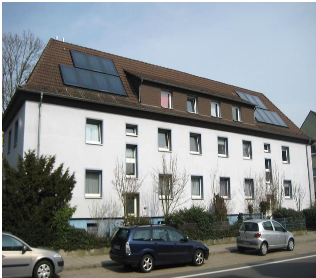
Objektbeispiel nach energetischer Modernisierung (Effizienzhaus 100)
